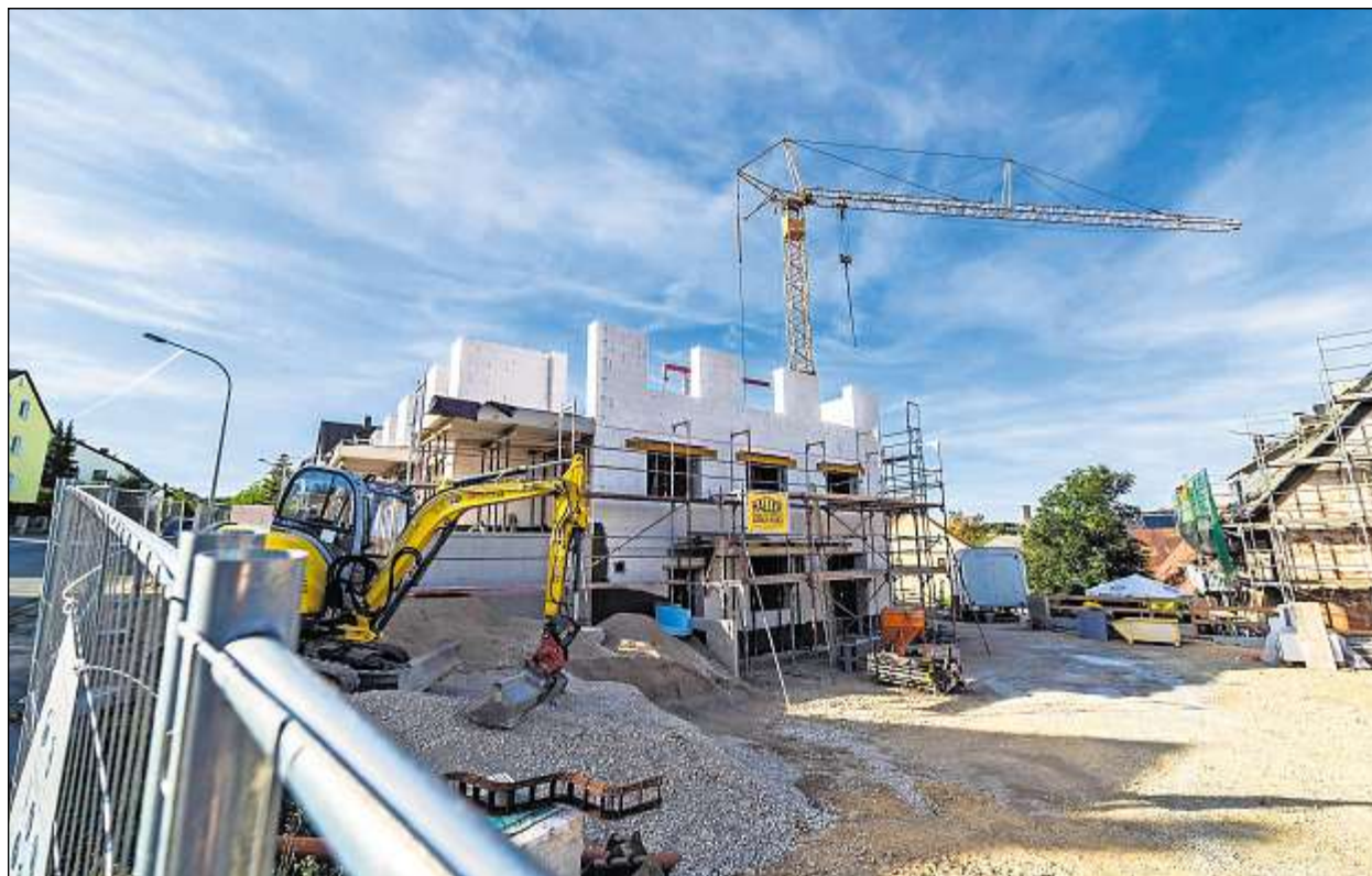
Dort, wo vor einiger Zeit noch der letzte Bauernhof in Pegnitz stand, entstehen 13 neue Wohnungen. Auch an anderen Stellen im Stadtgebiet wird derzeit fleißig gebaut, etwa in Buchau am Talweg. Foto: Hans von Draminski
